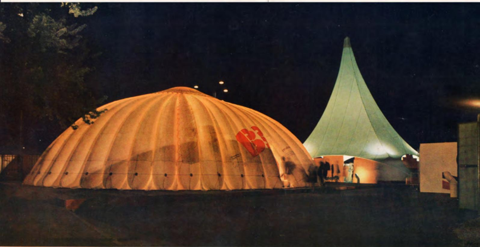
**IN UNA STRUTTURA PRESSOSTATICA AUTOPORTANTE
